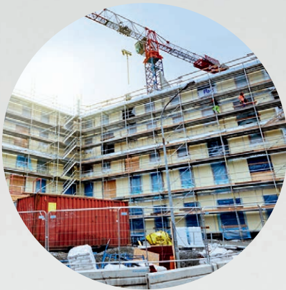
CHANTIERS DE CONSTRUCTION
